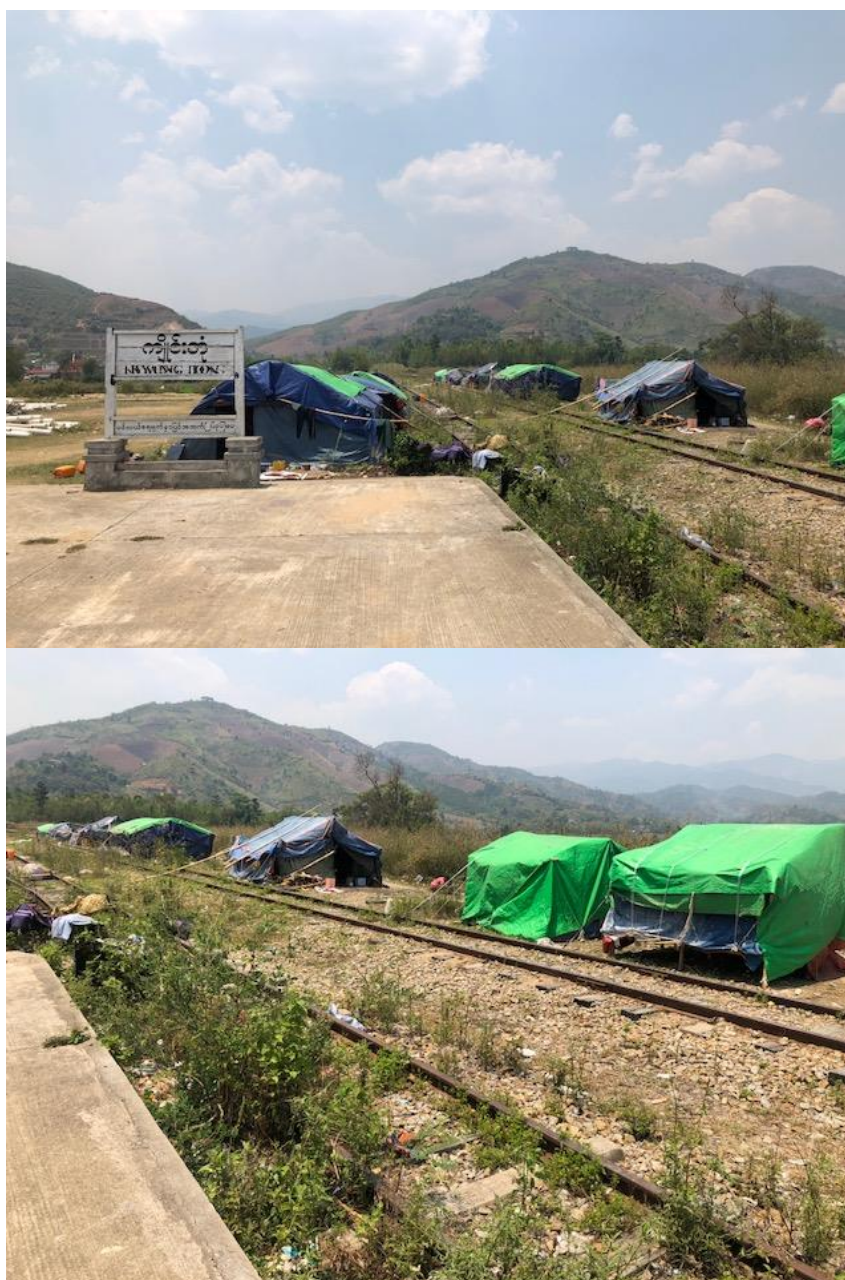
ภาพที่ 5.37 สถานีรถไฟเชียงตุงเชื่อมสู่ตองยี แต่ปัจจุบันเลิกใช้งานแล้ว เพราะเกิดภูเขาถล่มระหว่างเส้นทางเมื่อ 3 ปีก่อน จนถึงปัจจุบันยังไม่มีโครงการซ่อมแซม
