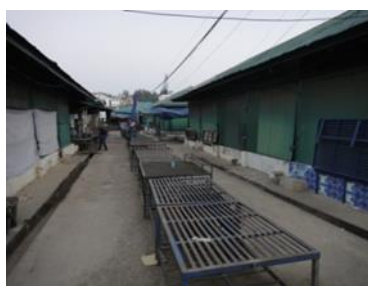
ภาพที่ 4.4 อาคารภายใน บริเวณกาด ประเภท 2
